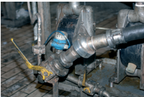
Abbildung 16b: Verlegen von Schlauchleitungen – Kugeldrehgelenk
